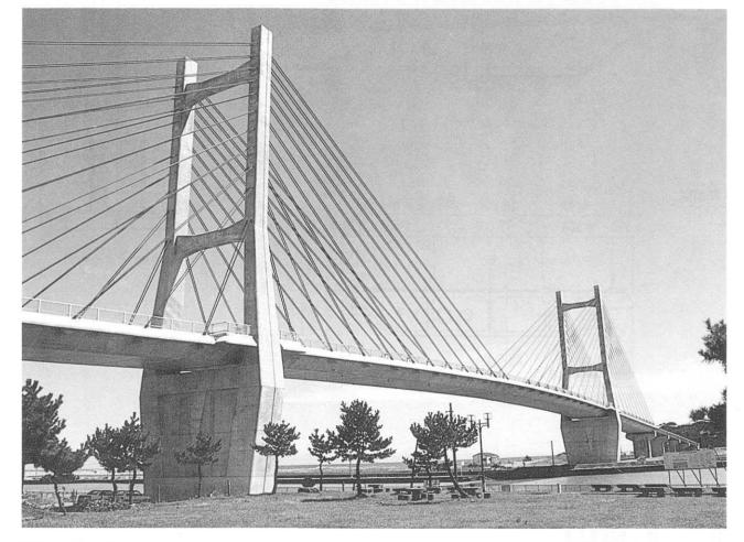
■キーワード ●フローチングタイプの3径間連続PC斜張橋 ●ウインドノーズを持つ桁 ●2面吊り斜張橋 ●RC構造の主桁の張出し架設 ●コンクリート塗装 ●制振装置として粘性せん断型ダンパーおよび粘弾性型ダンパーを使用 ●特殊作業車(2主桁4支点構造)
