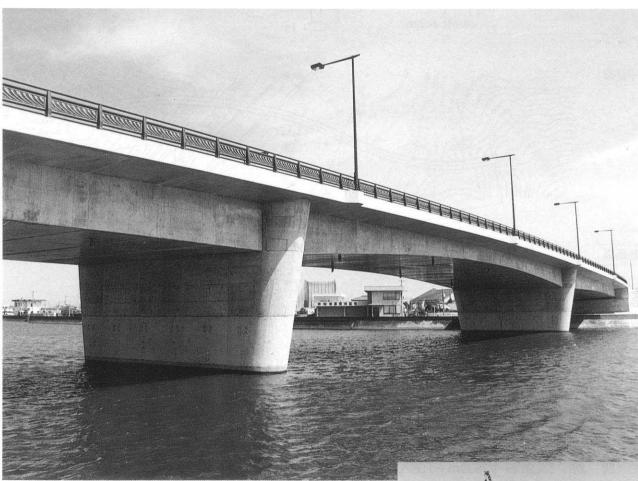
■キーワード●4主桁大型移動作業車を用いた施工●国内最大規模の大幅員カンチレバー施工
