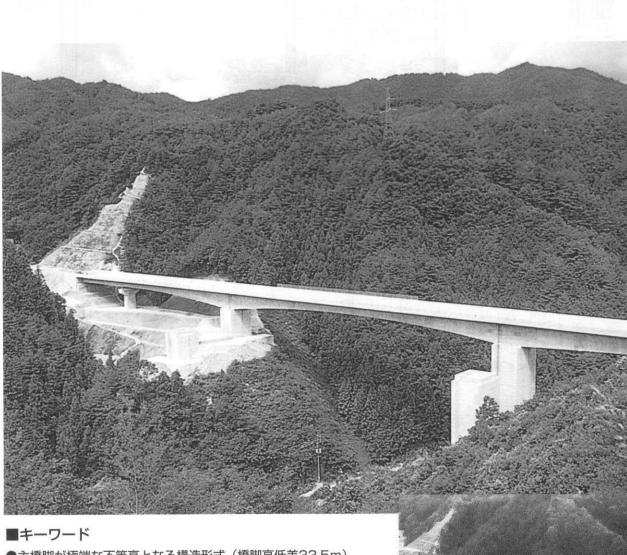
●主橋脚が極端な不等高となる構造形式(橋脚高低差33.5m) ●右側側径間の架設に際し仮支柱を補助工法とする施工方法 ●昭和56年度PC技術協会作品賞受賞
