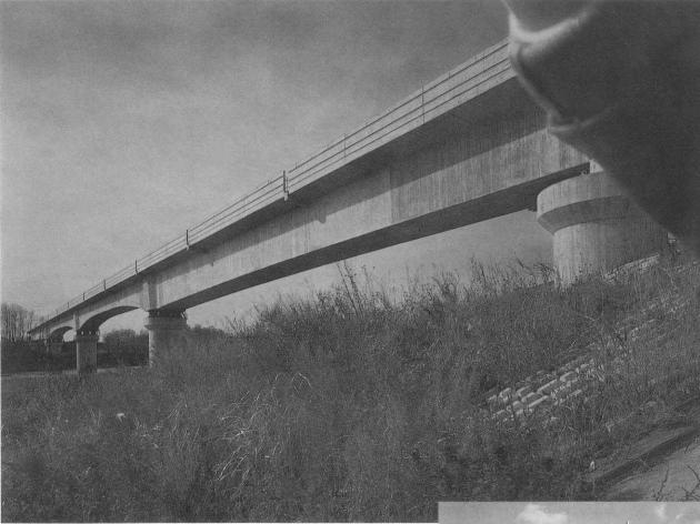
■キーワード ●硬化熱によるひび割れ防止のための温床線の使用や発熱量の 少ないコンクリート配合の研究
